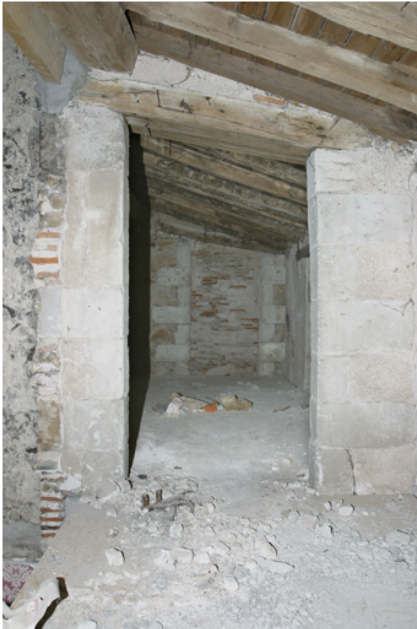
Le corps secondaire : vue de l'étage de comble depuis l'escalier.
