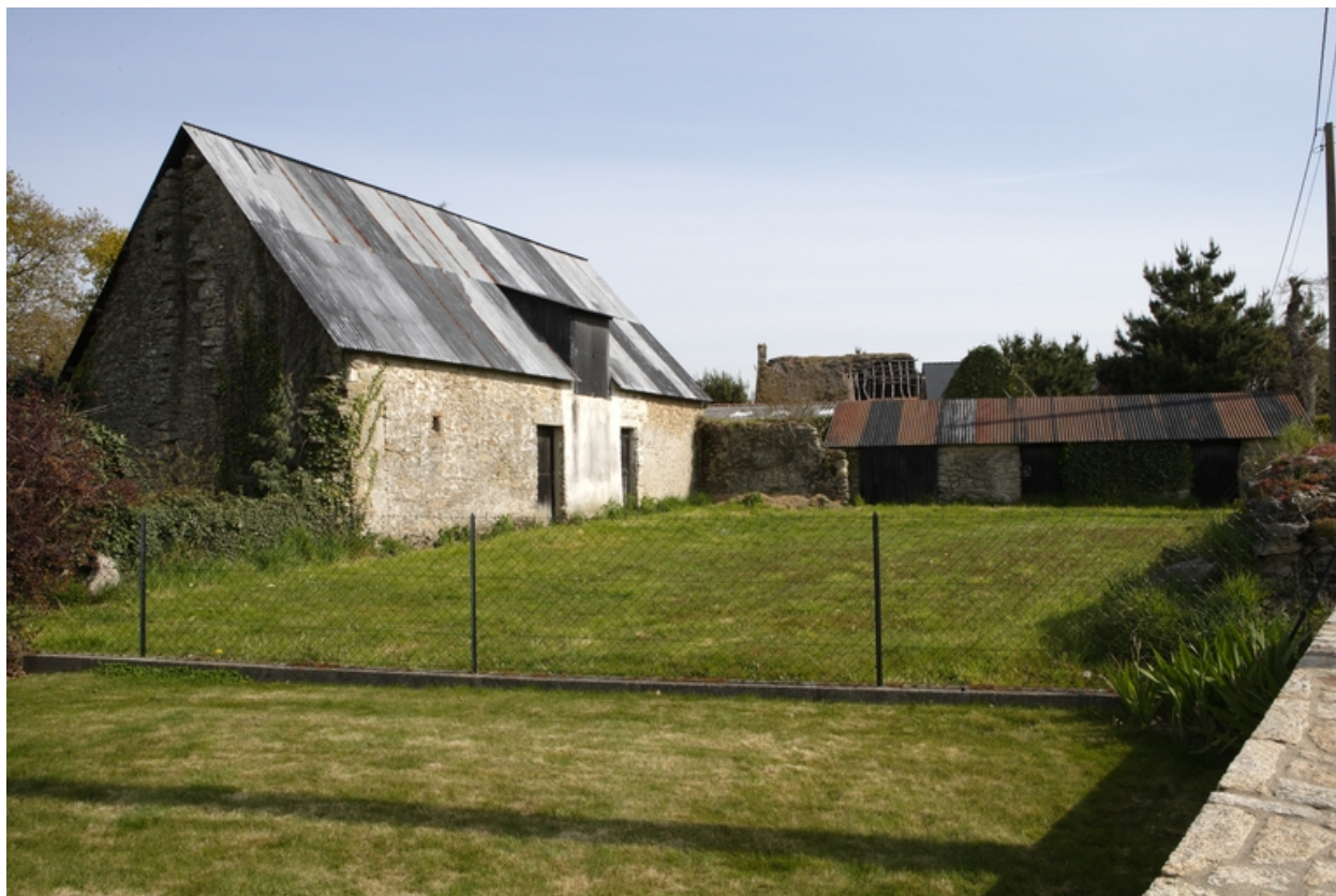
Vue d'ensemble actuelle depuis le nord-ouest.
