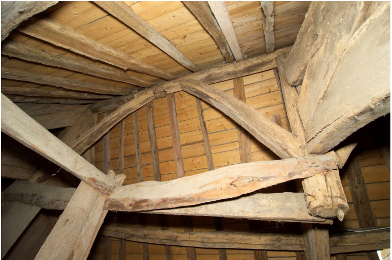
détail de la charpente, poinçon scié.
