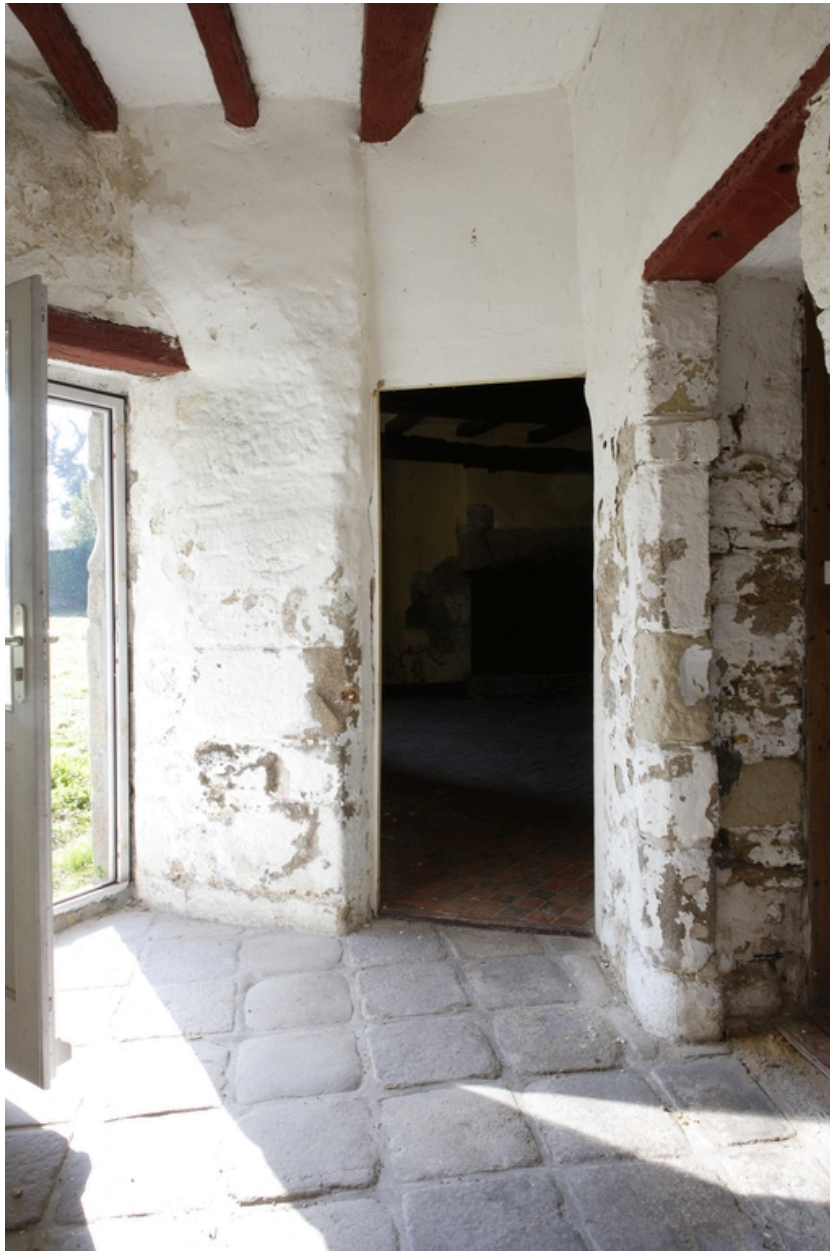
Aile ouest. Porte d'accès à la salle basse.
