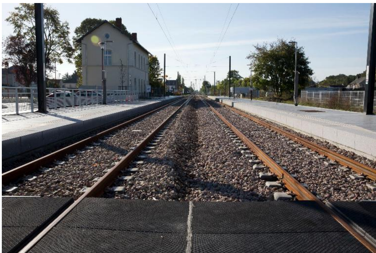
Voies et bâtiment des voyageurs à la gare de Nort-sur-Erdre.
