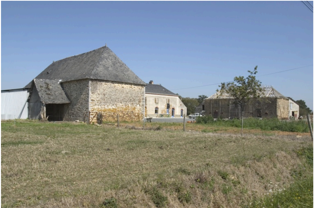
Vue d'ensemble depuis le sud-ouest : l'étable à chevaux-remise, le logis, l'étable-grange.
