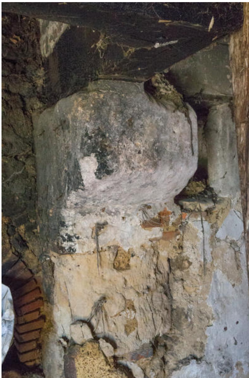
Cheminée : corbeau de droite.
