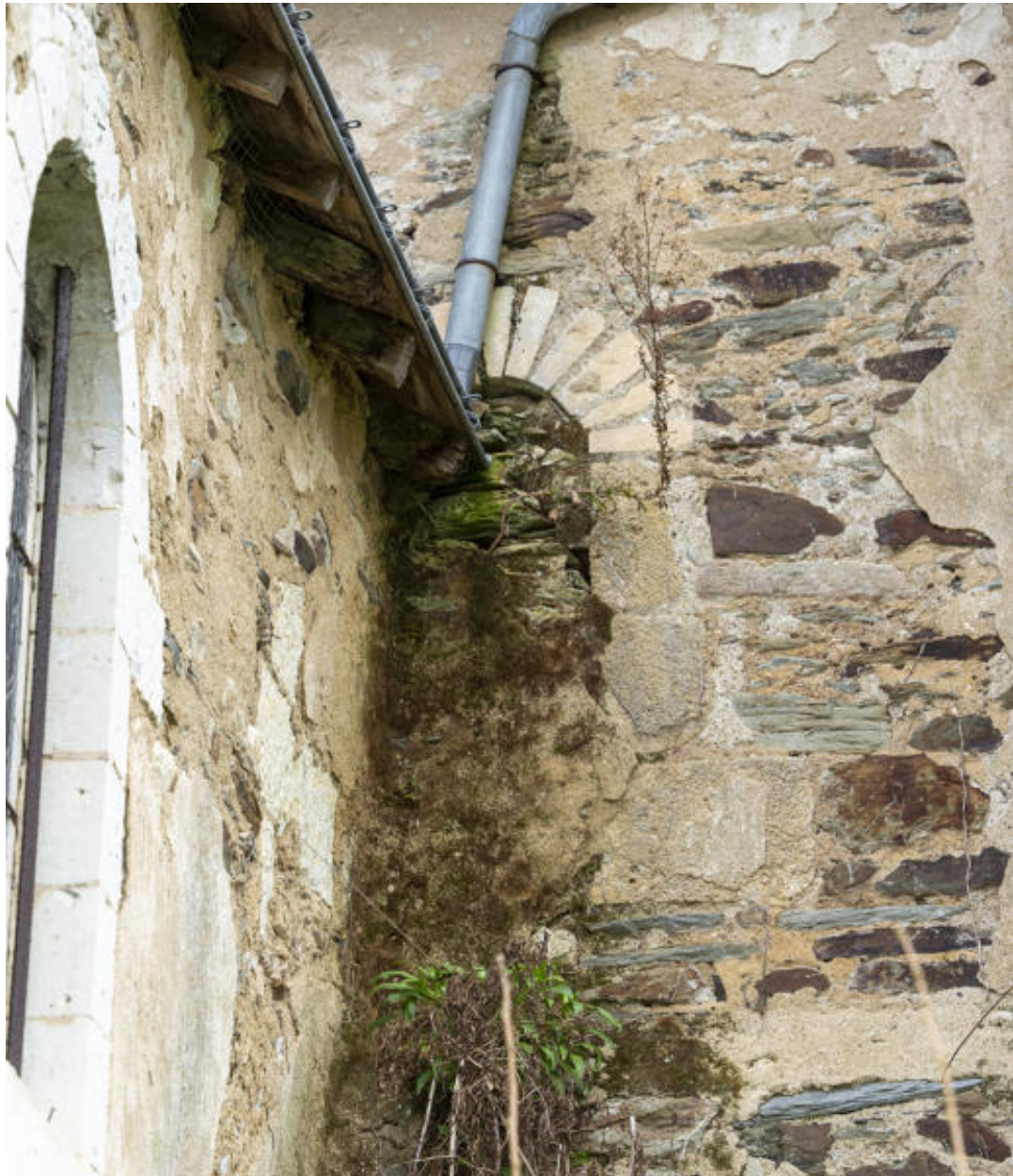
Une ancienne baie romane à la jonction du bras sud du transept.
