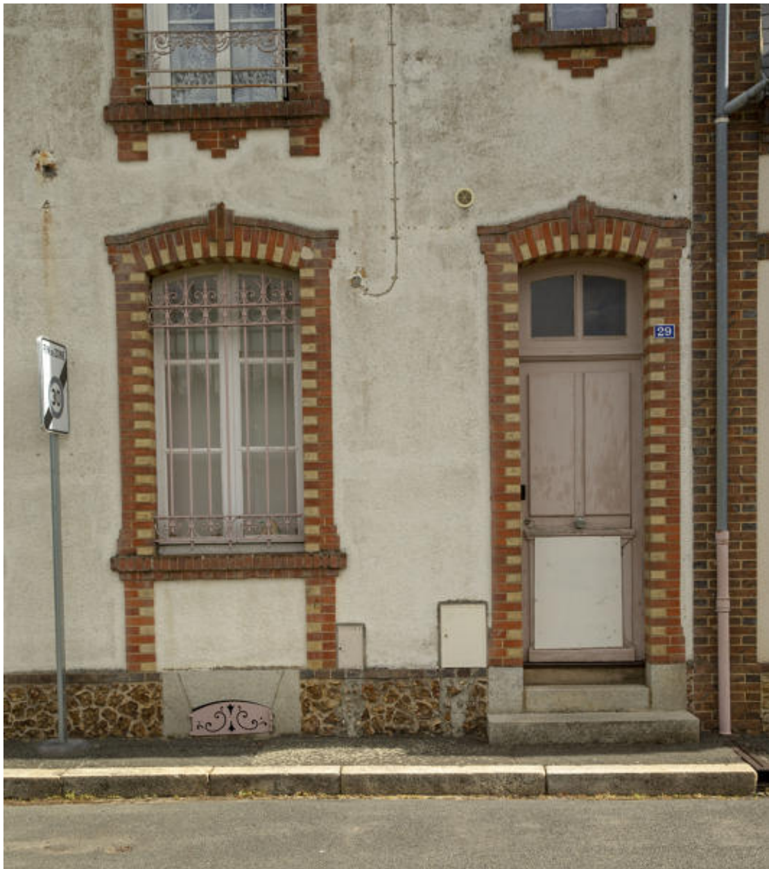
Un détail du rez-de-chaussée.
