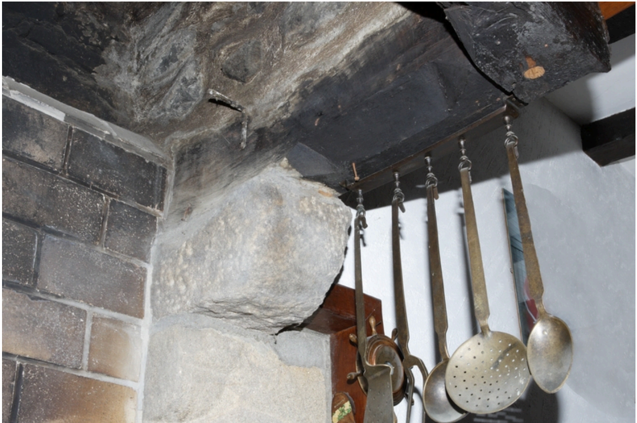
Détail du corbeau de droite de la cheminée du n° 25.
