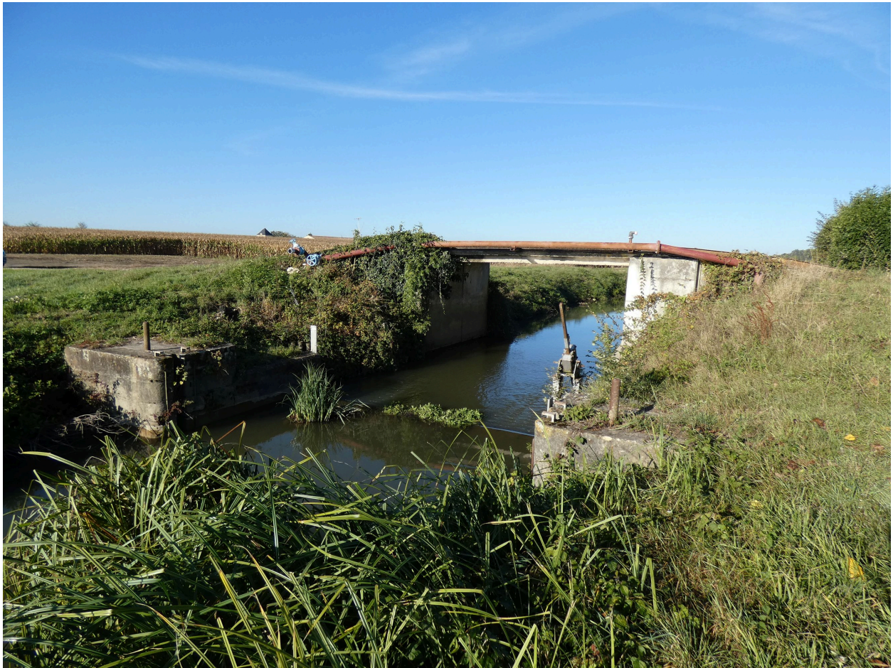
Pont et barrage mobile sur le canal de Reth, au nord-est de la Petite Bernegoue.
