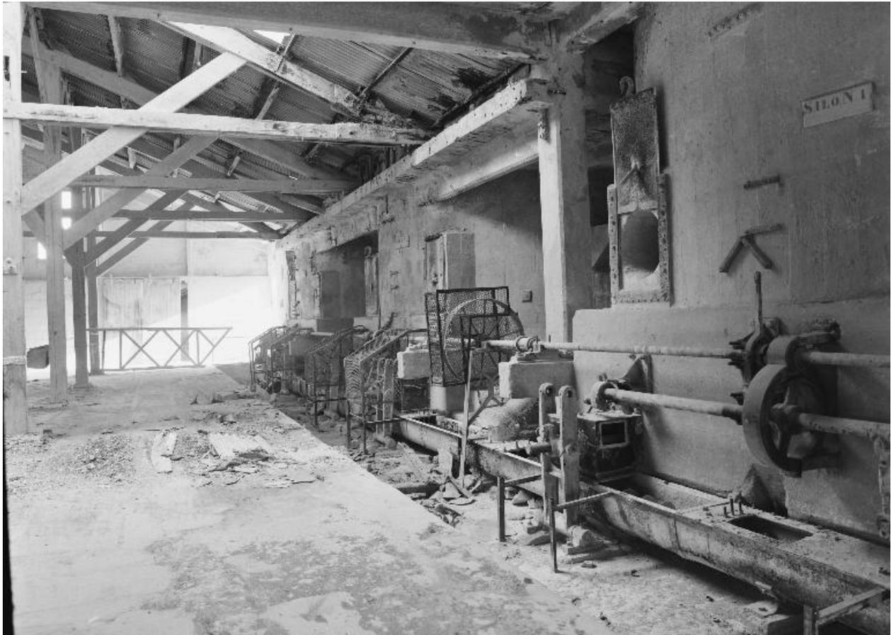
Usine de chaux, atelier de blutage ; déchargement mécanique à la base des silos
