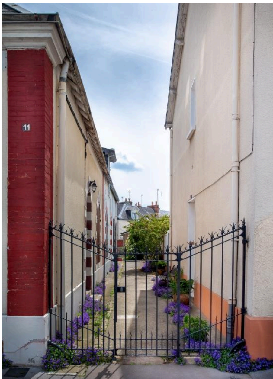
Vue du portail d'entrée côté rue Ambroise-Paré.
