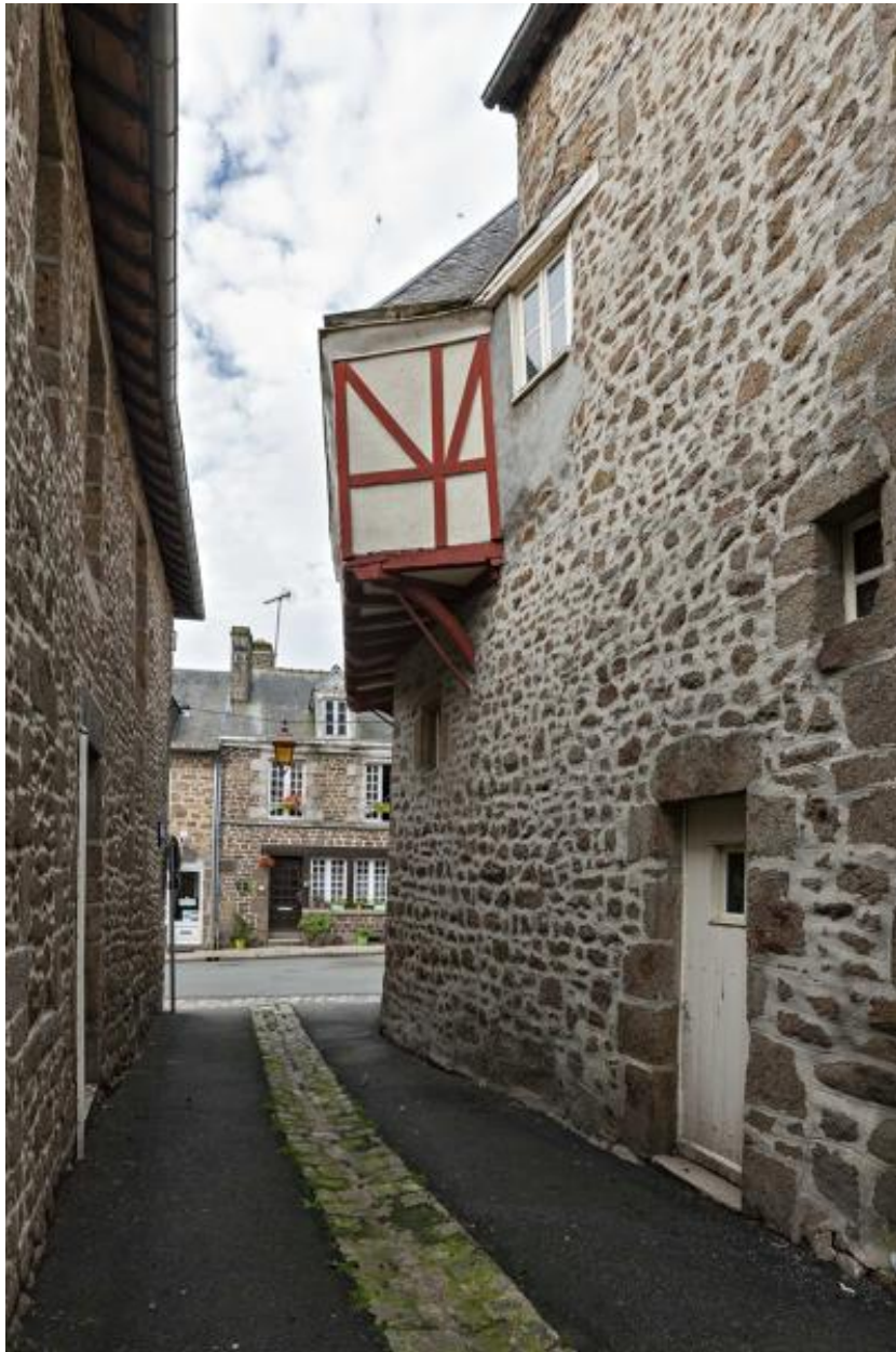
Maison du 1 rue Dorée, pièce en encorbellement sur la rue Dorée, côté sud-est.
