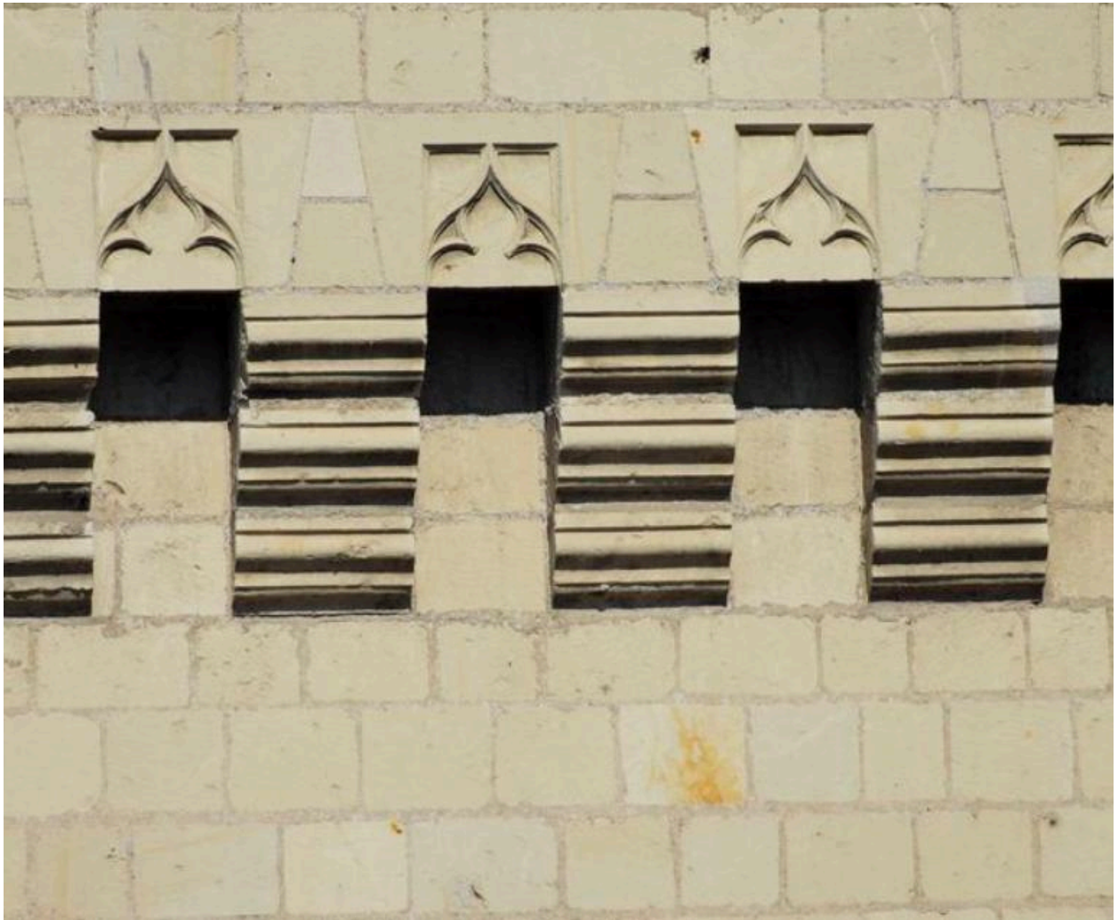
Mâchicoulis (2), corps principal, façade sud, partie centrale.
