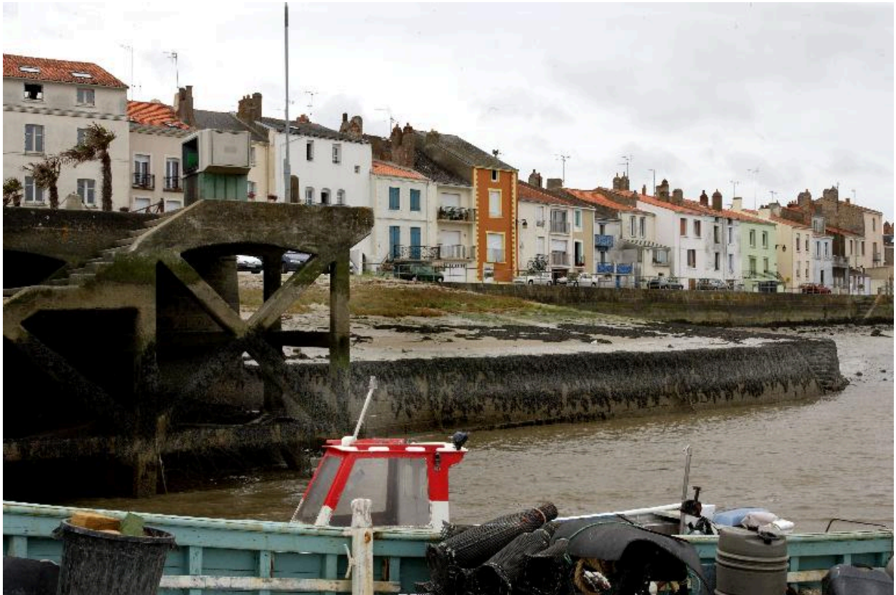
Vue du quai Boulay-Paty, au centre, la maison n° 78.
