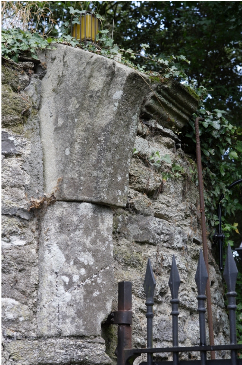
Mur de clôture. Portail d'entrée. Détail de la moulure de l'arc.
