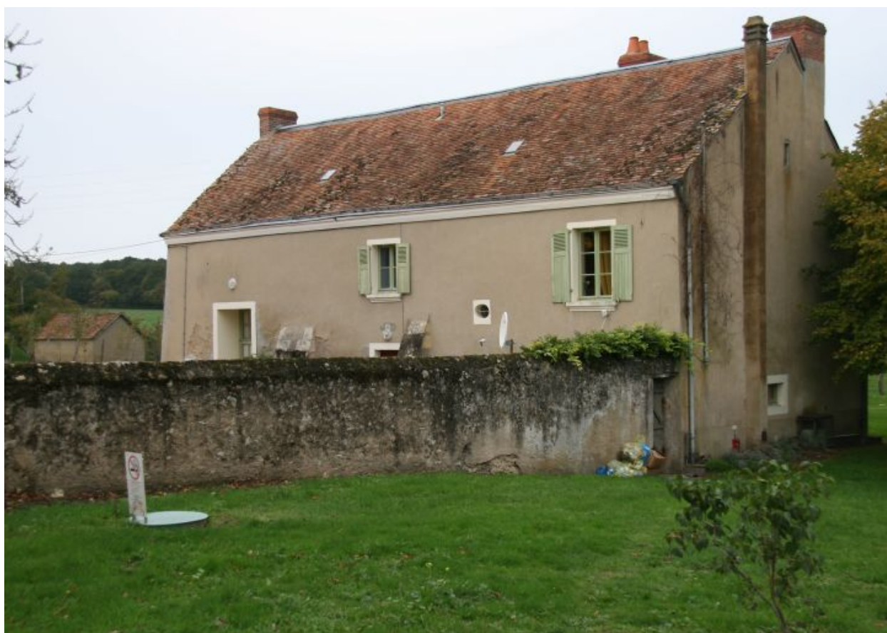
Façade postérieure et mur de clôture.
