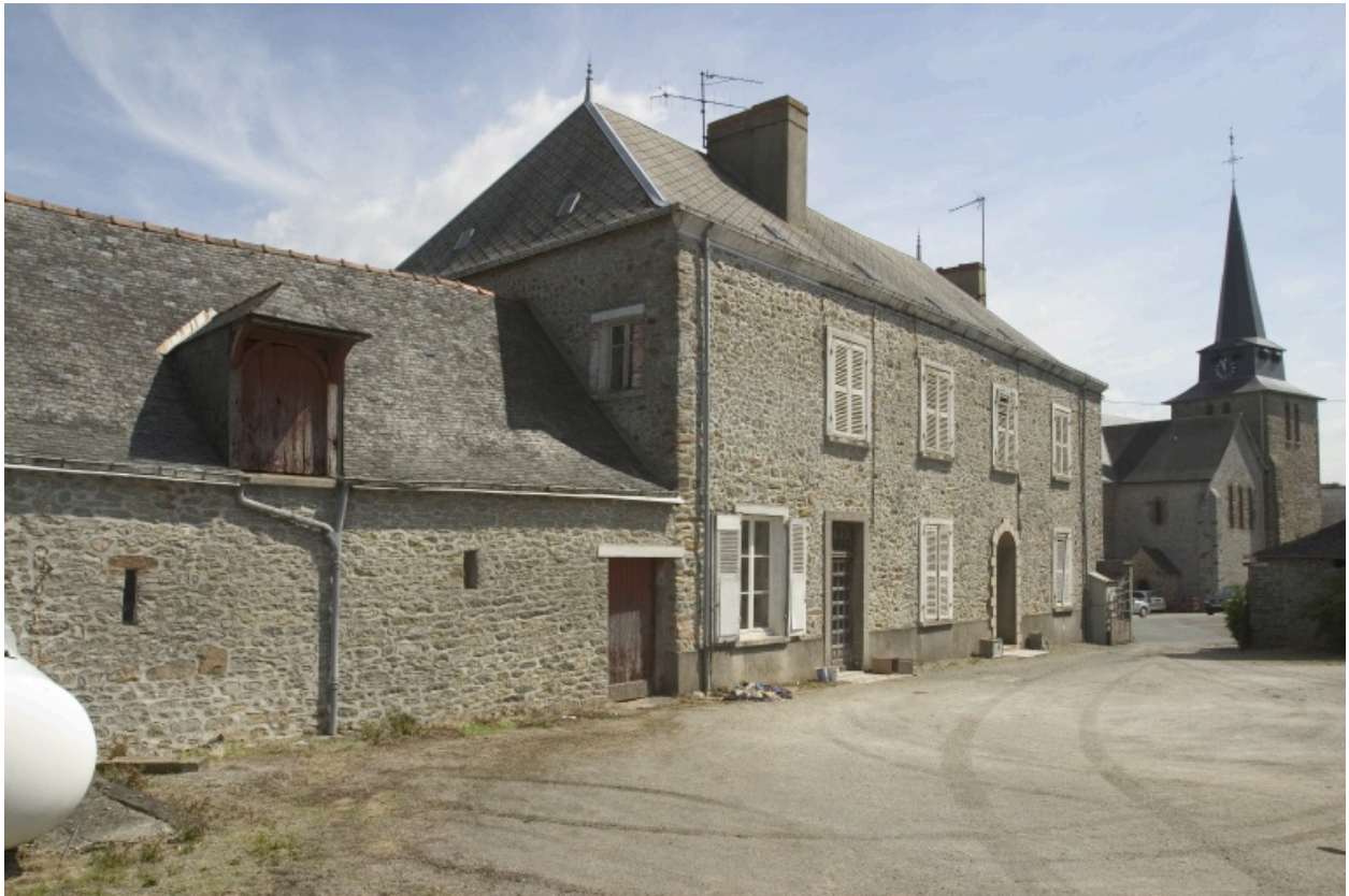
L'élévation sud du logis et la dépendance contigüe, vues depuis la cour.
