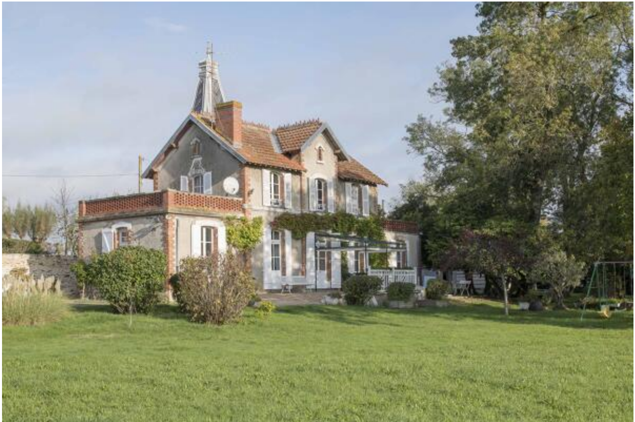
Vue d'ensemble depuis le jardin.
