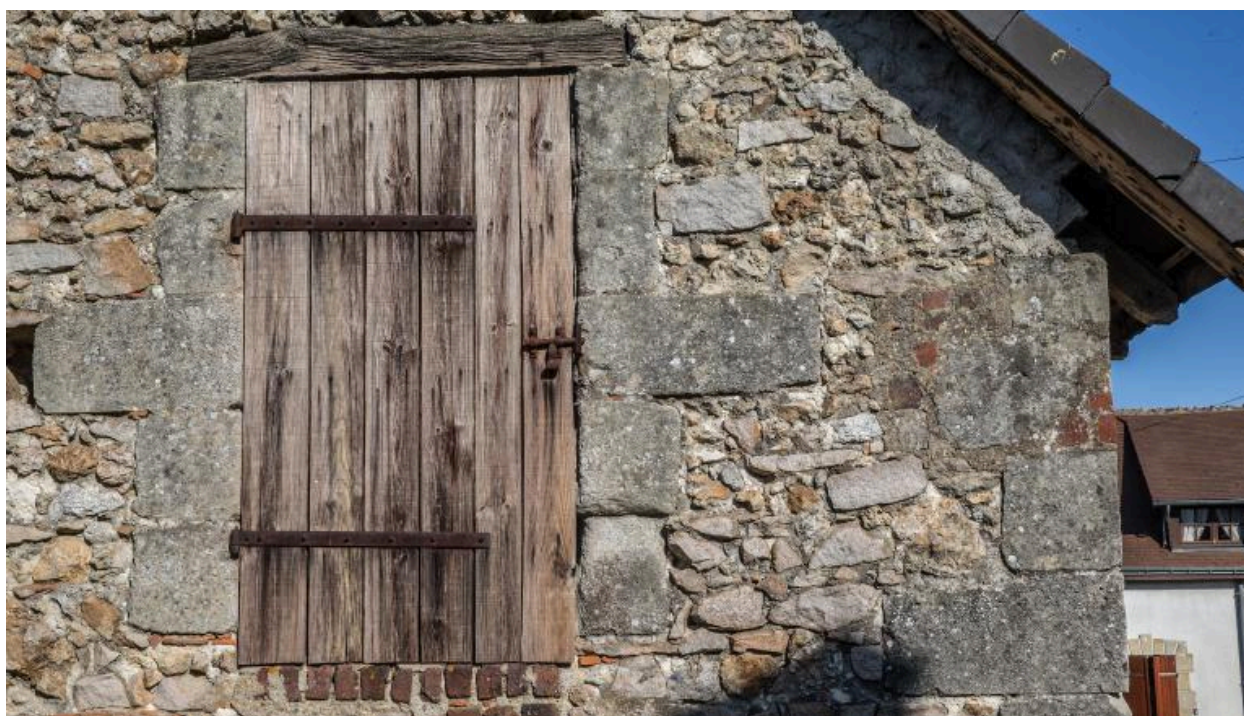
Détail de maçonnerie.
