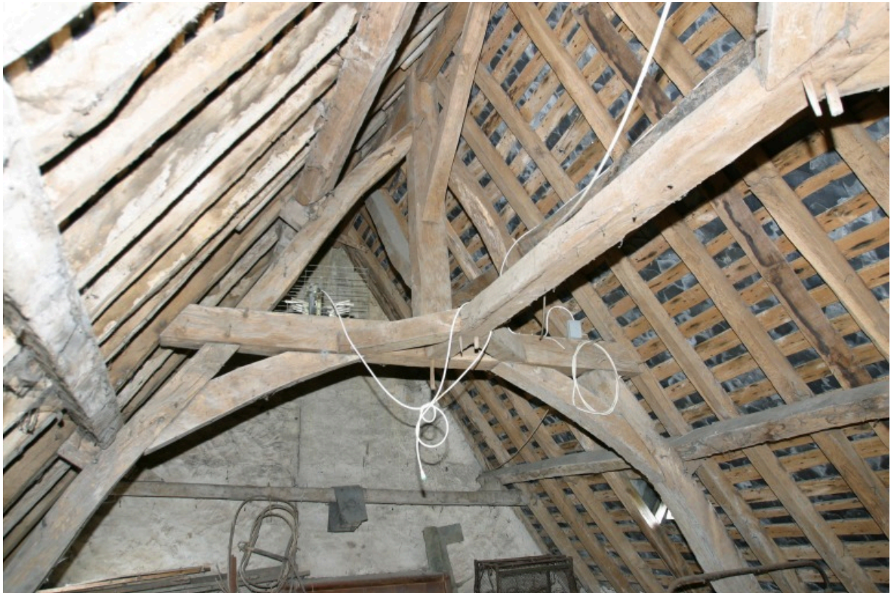
L'aile ouest, comble : la charpente vue depuis le sud.
