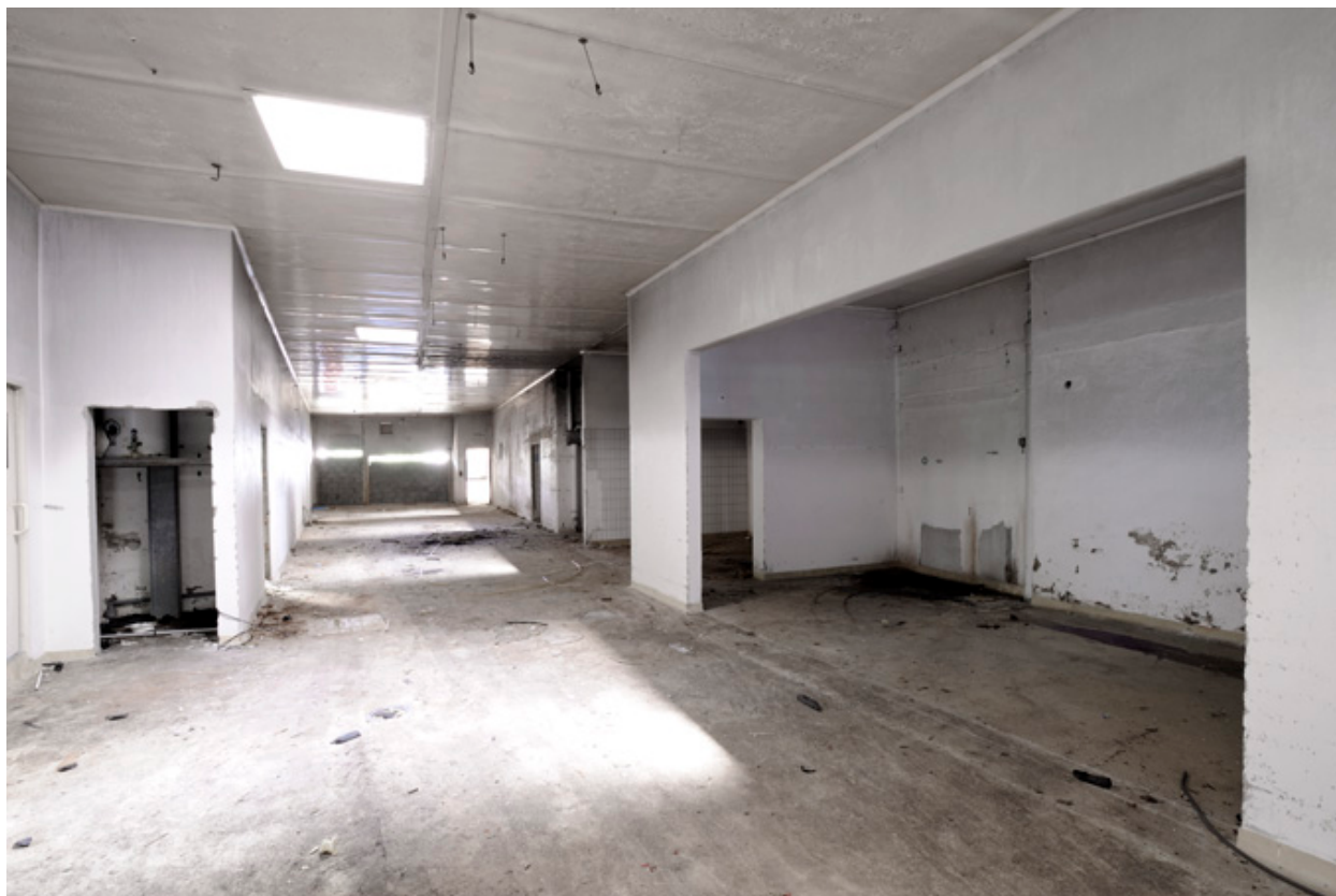
Laiterie-fromagerie Gallais : atelier de fabrication et hâloirs.
