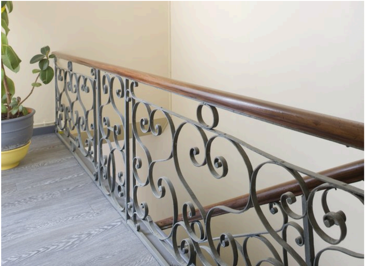
Détail du garde-corps de l'escalier.
