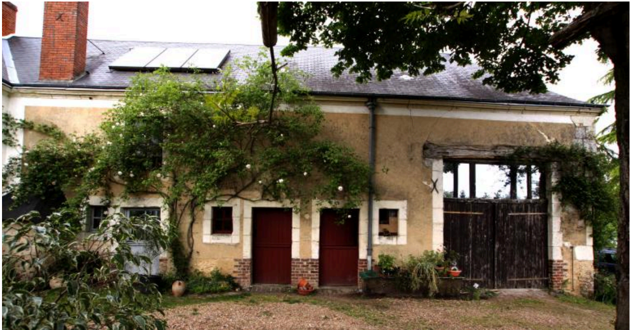
Maison et dépendance, façades sur cour.
