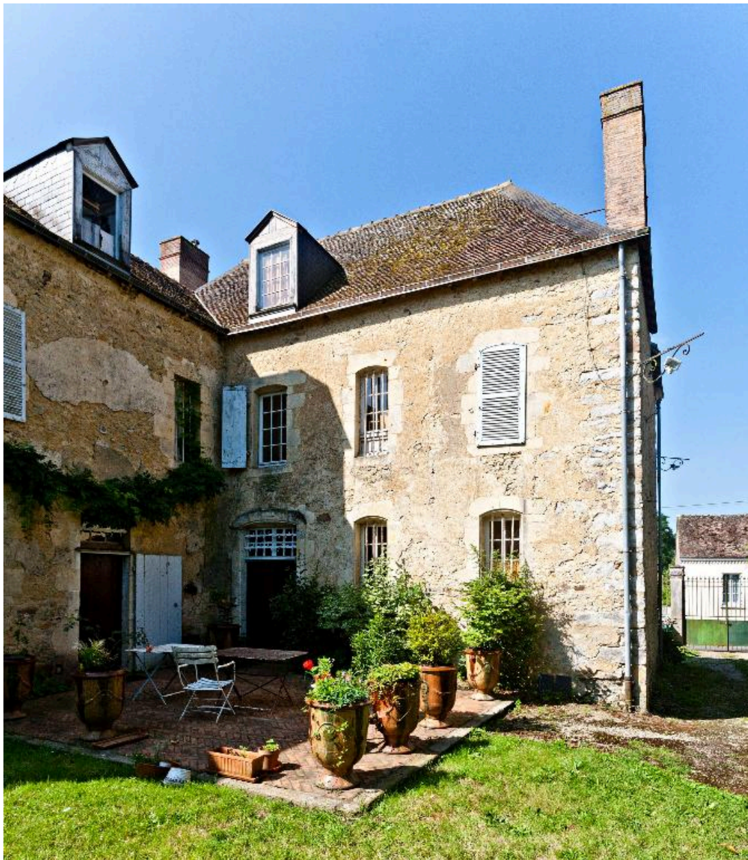
Elévation postérieure du logis.
