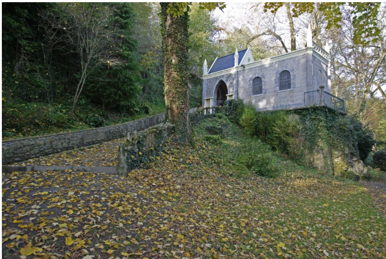
Vue depuis le sud.
