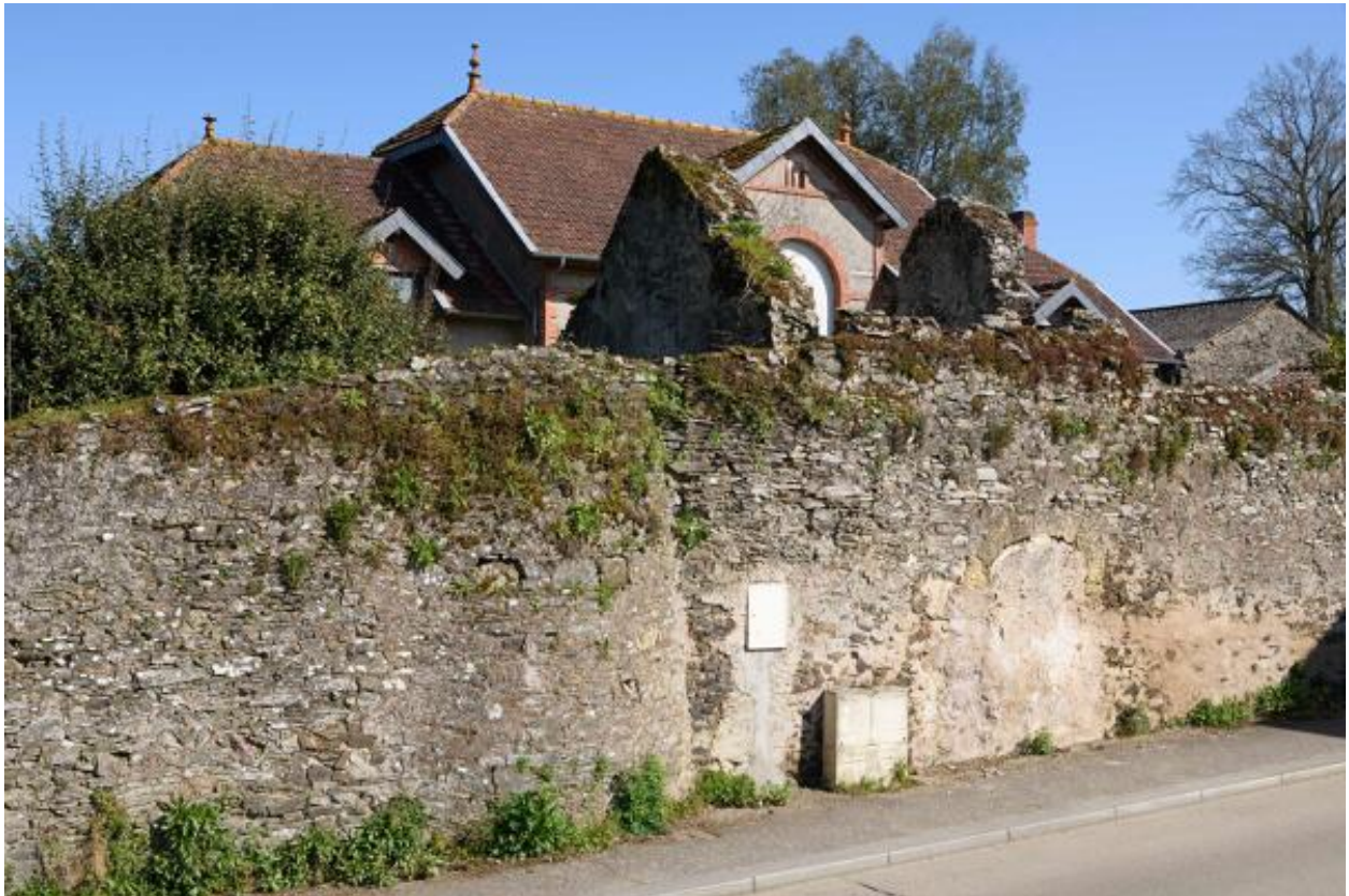
Vue du mur de clôture et vestige d'une tourelle depuis l'ouest.
