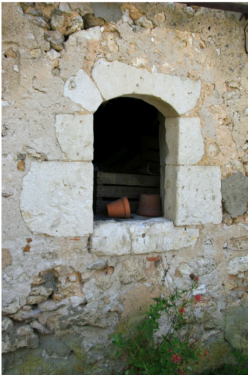
Les étables : détail d'une baie.
