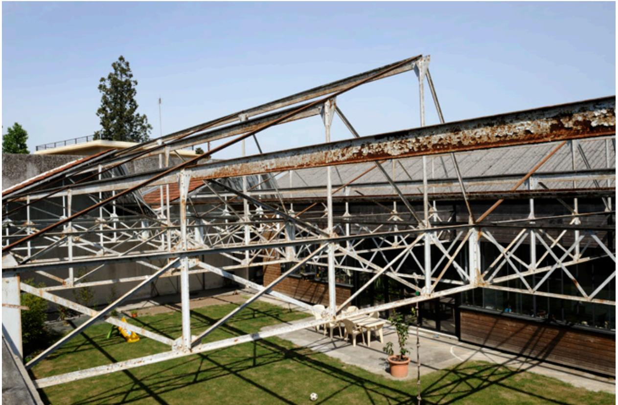
Détail des charpentes métalliques (sheds et toit à longs pans) des vaisseaux construits en 1933-1934.
