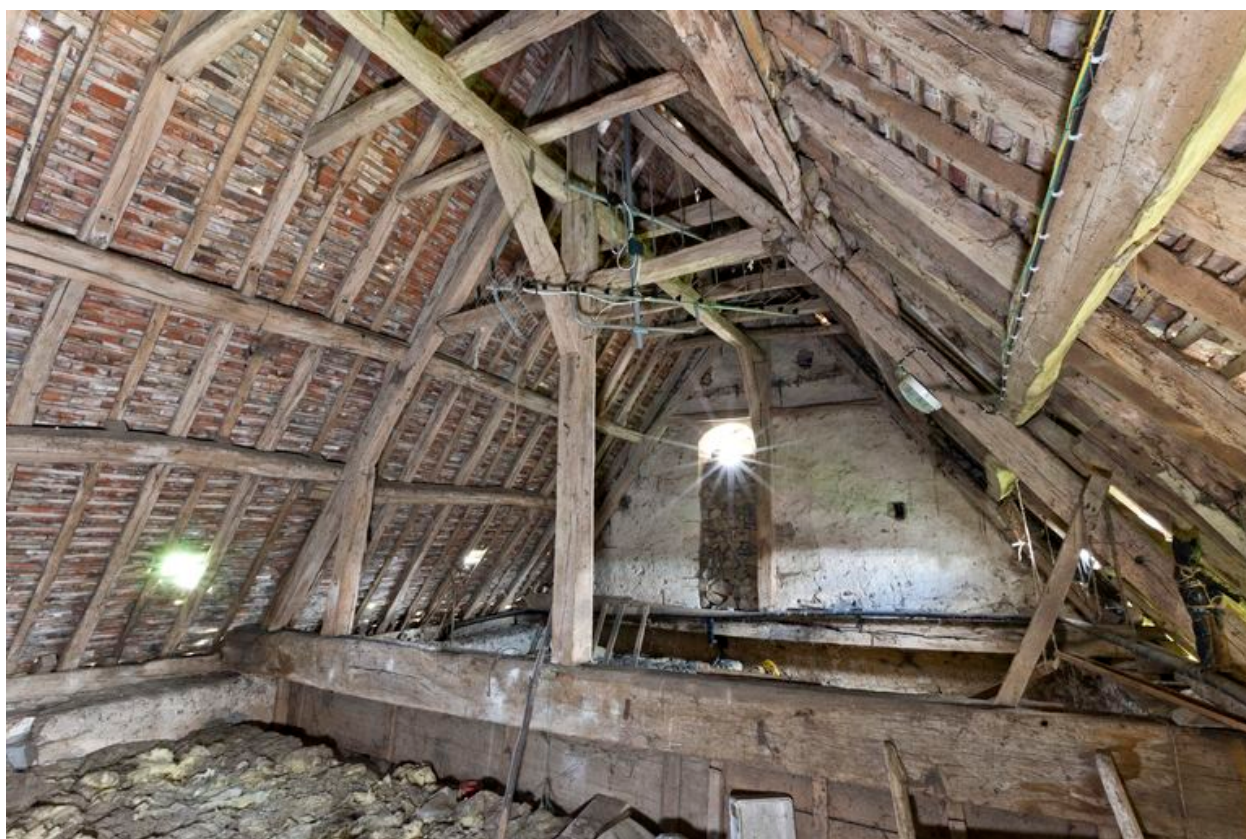
Vue intérieure du comble du corps principal.
