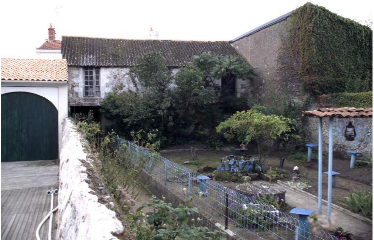
L'atelier-logement aligné sur la rue Saint-Gilles, vu depuis le jardin.
