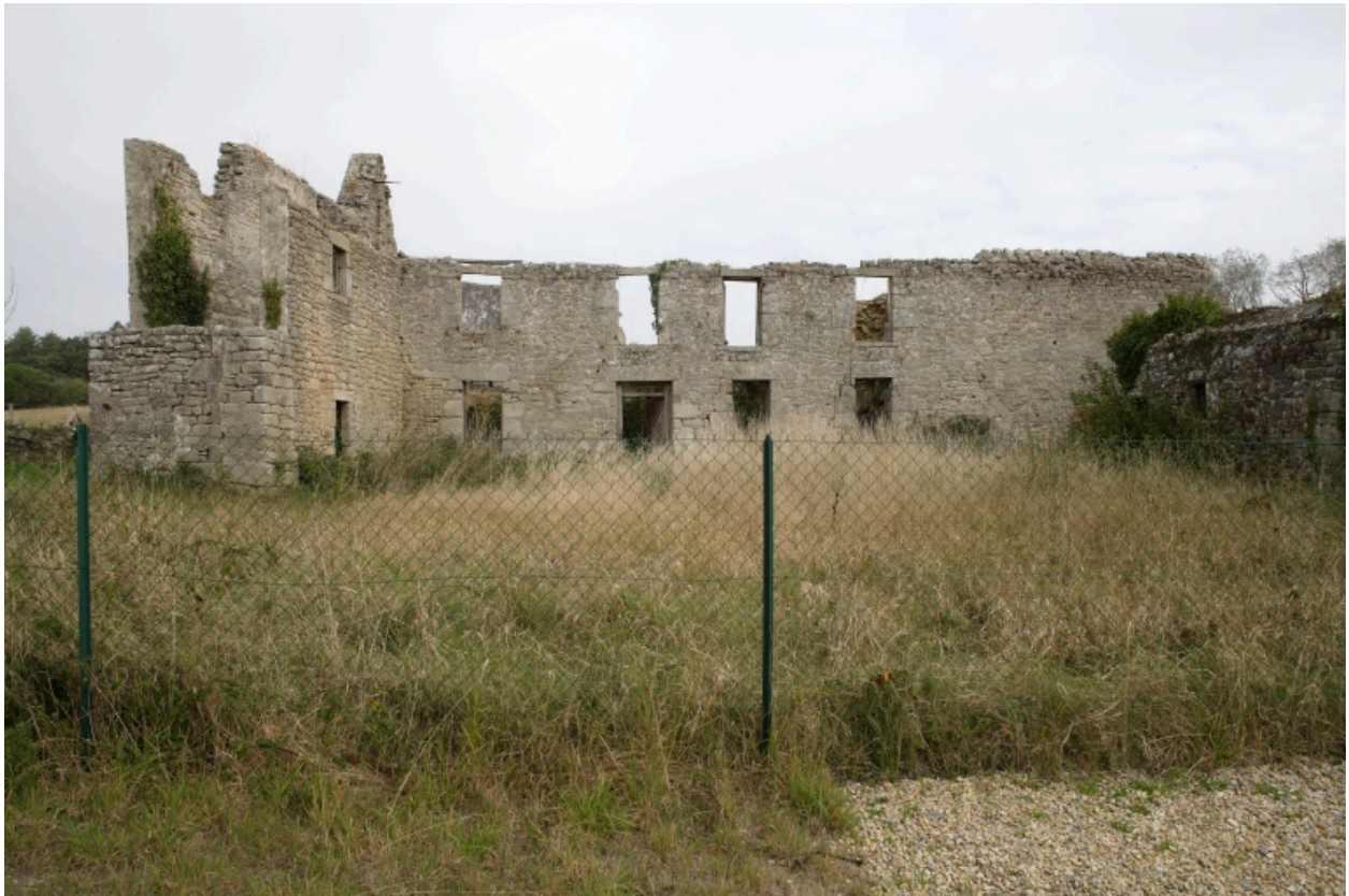
Logis. Aile sud. Façade sud.
