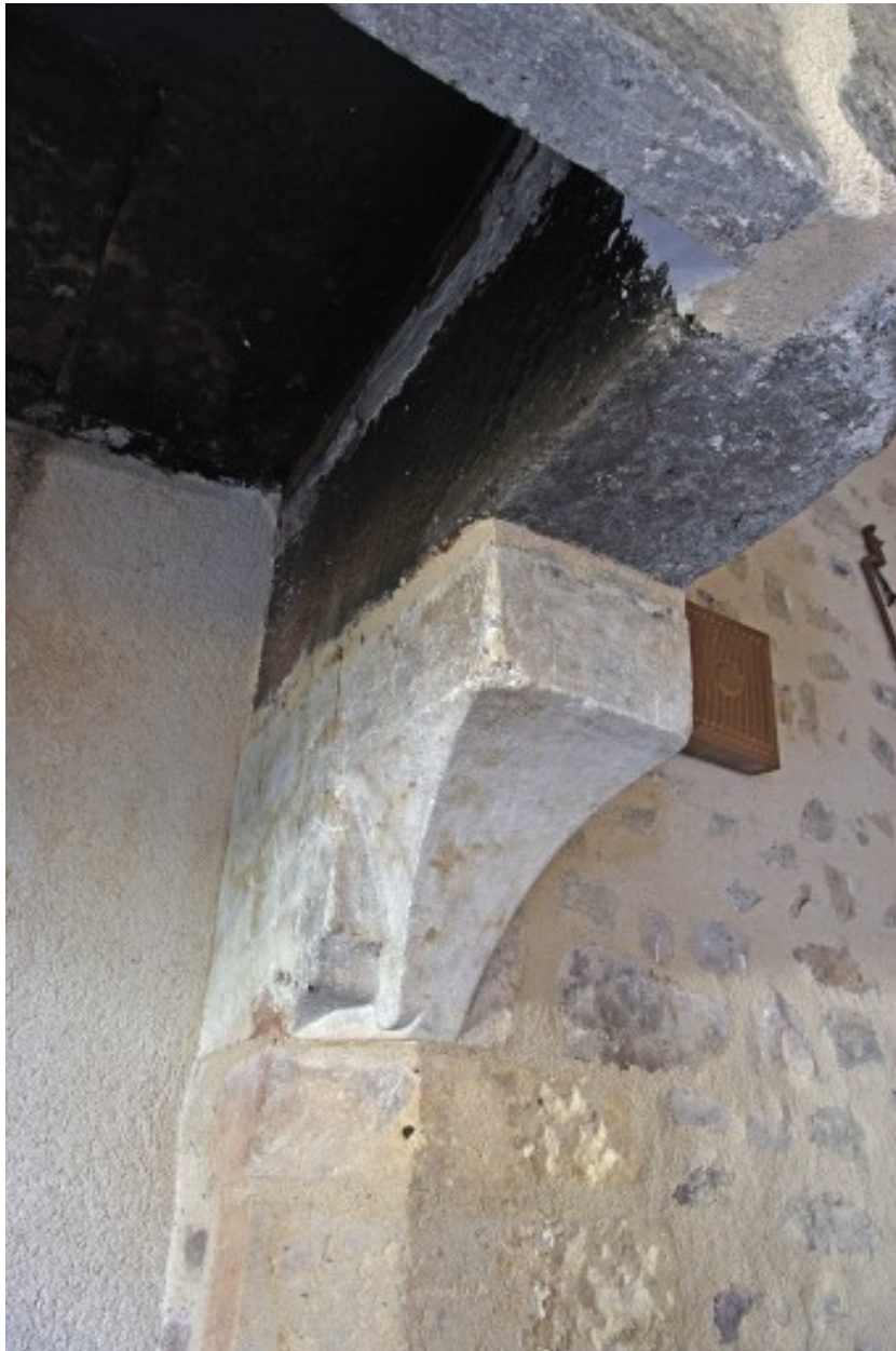
Rez-de-chaussée du pavillon, pièce sud : le corbeau droit de la cheminée.
