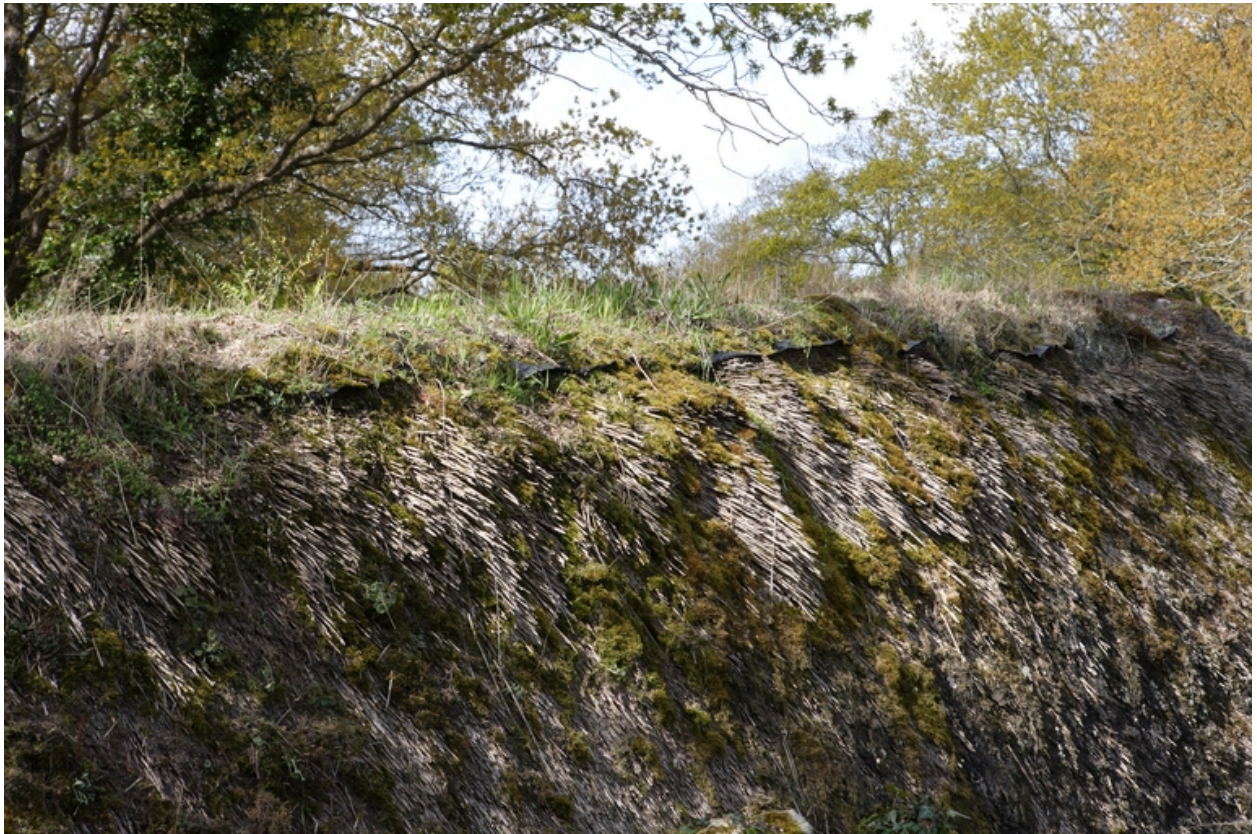
Détail de la couverture de la remise.
