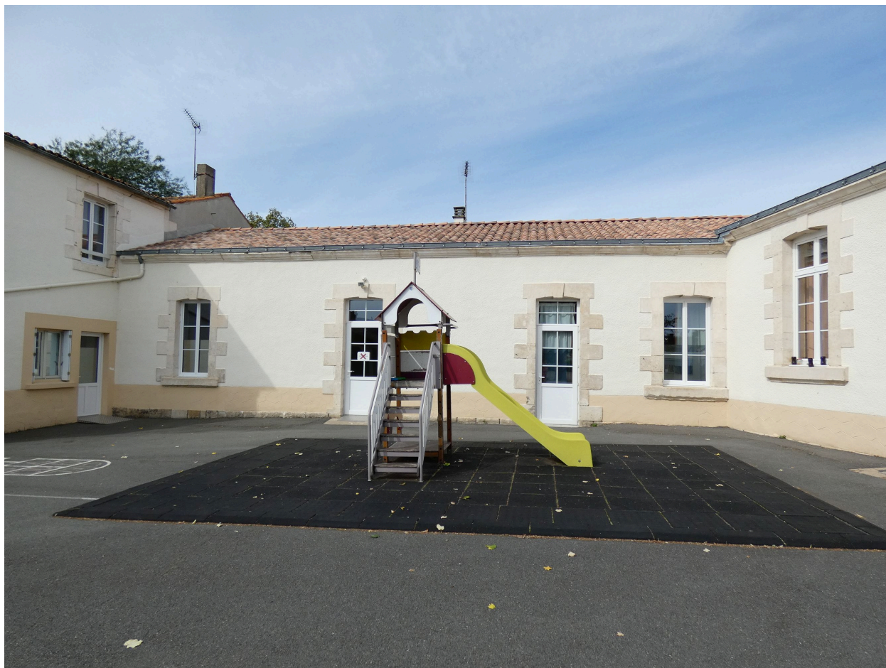
Le bâtiment de classe ouest, construit en 1874 et réaménagé en 1884, vu depuis l'est.
