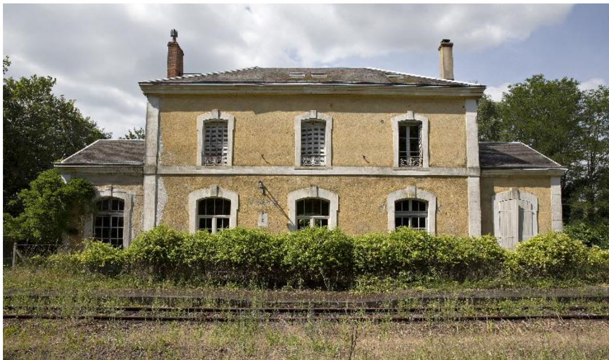
Les rails, au-devant du bâtiment voyageurs côté quai.
