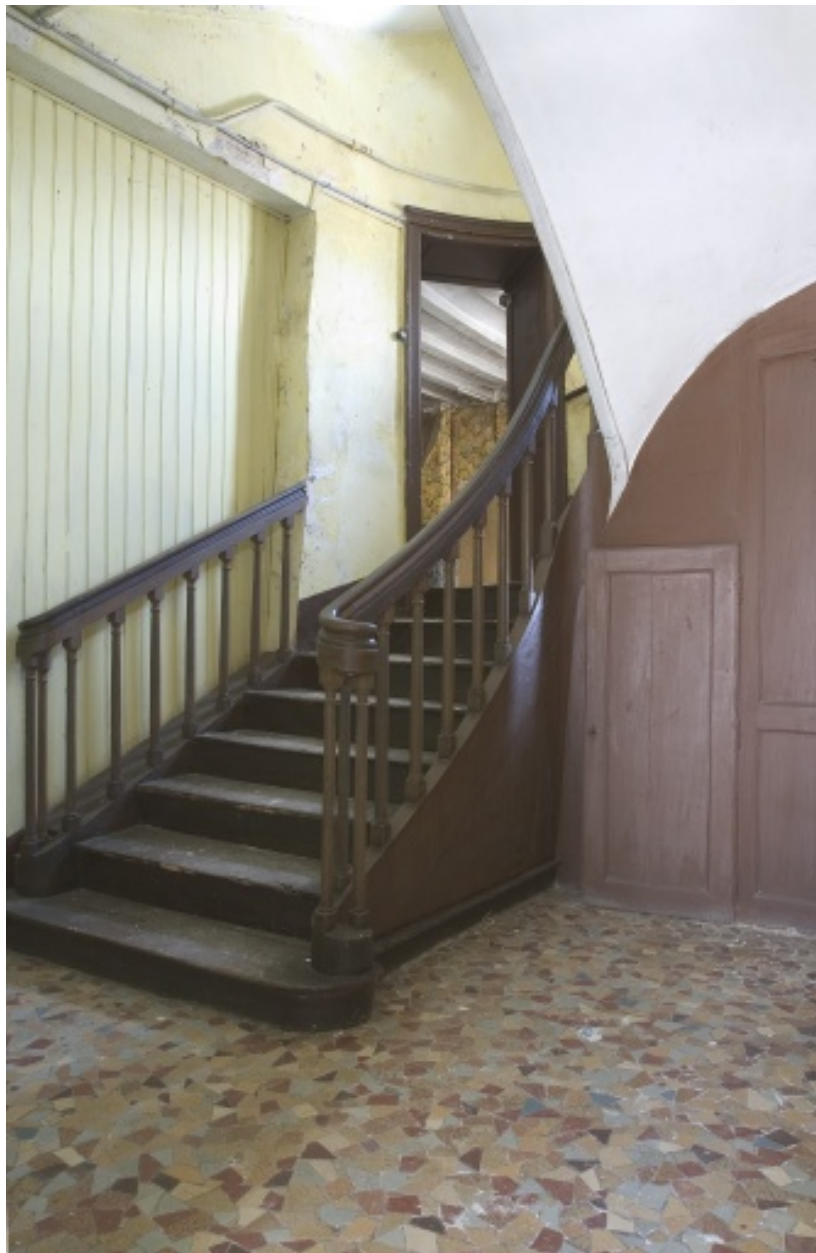
L'escalier et la porte de la chambre située dans l'appentis vus depuis le rez-de-chaussée.
