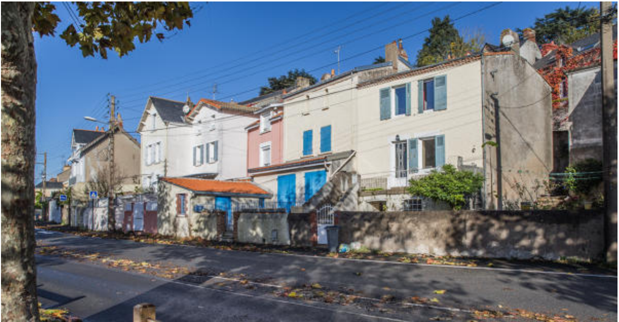
Alignement de maisons, quai Henri-Brunais.
