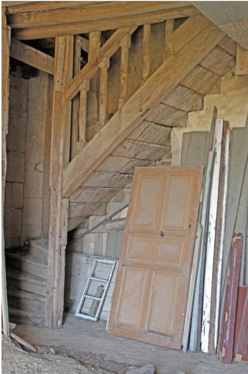
Pavillon, étage côté cour, chambre à feu : escalier menant au comble.
