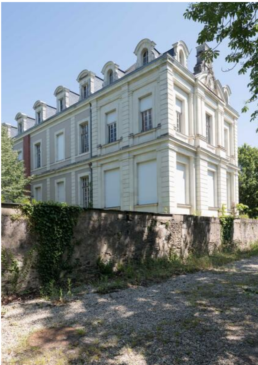
Quartier des hommes. Vue du bâtiment n° 1 construit par Ernest Dainville en 1891.
