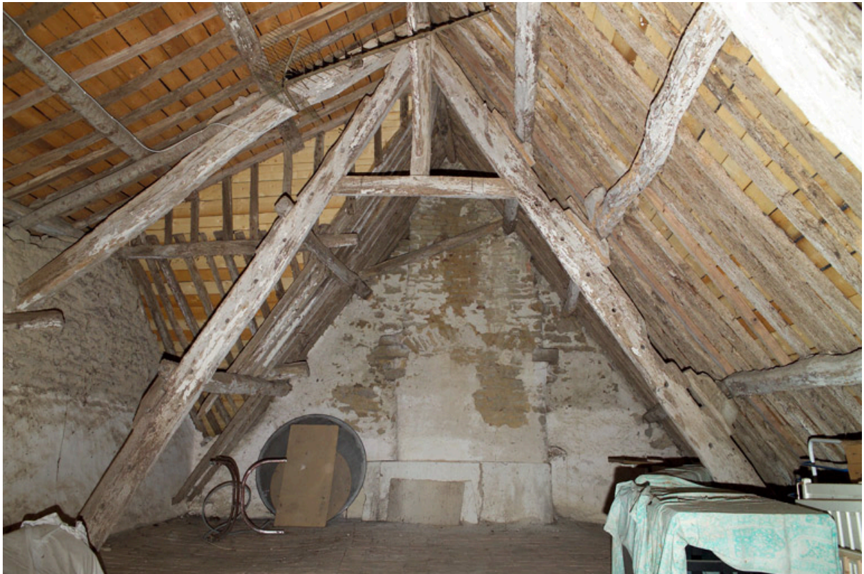
Charpente du logis.
