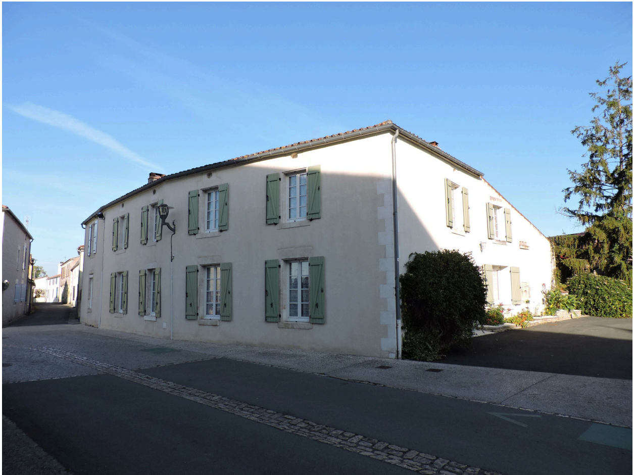
La maison vue depuis le sud-est.
