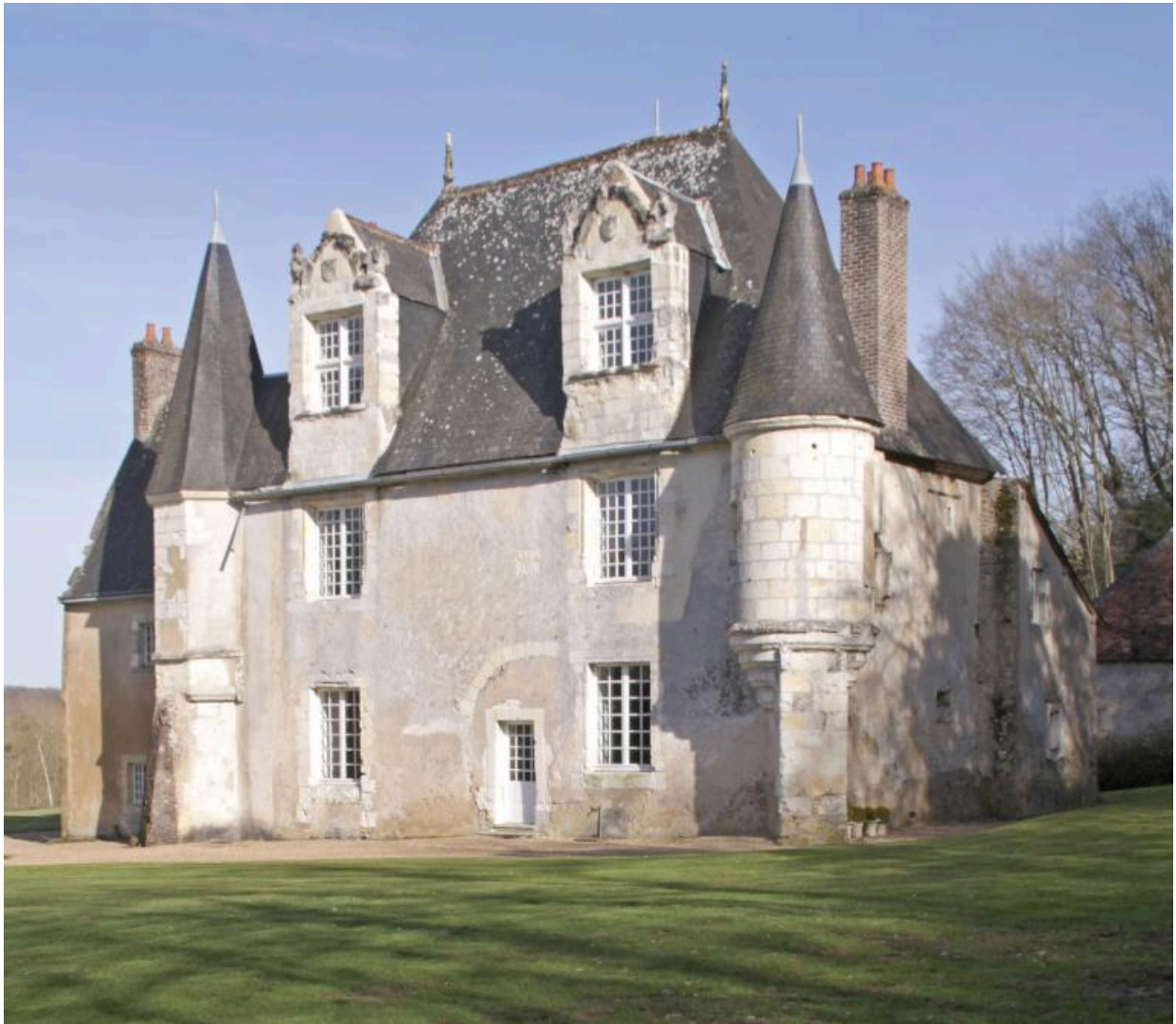
Vue de volume prise depuis le sud-ouest.
