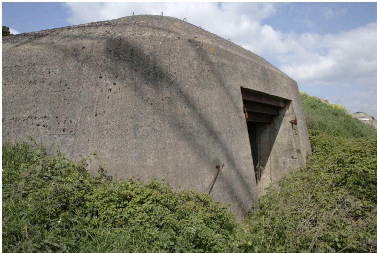
Vue de la casemate n° 3.
