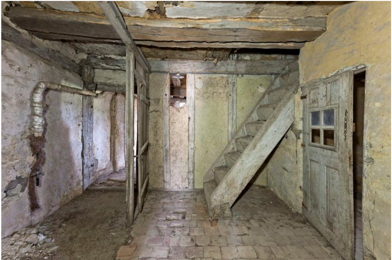
Vue intérieure de la pièce 2 : à droite, palier (?) de l'escalier disparu, échelle d'accès au comble à gauche
