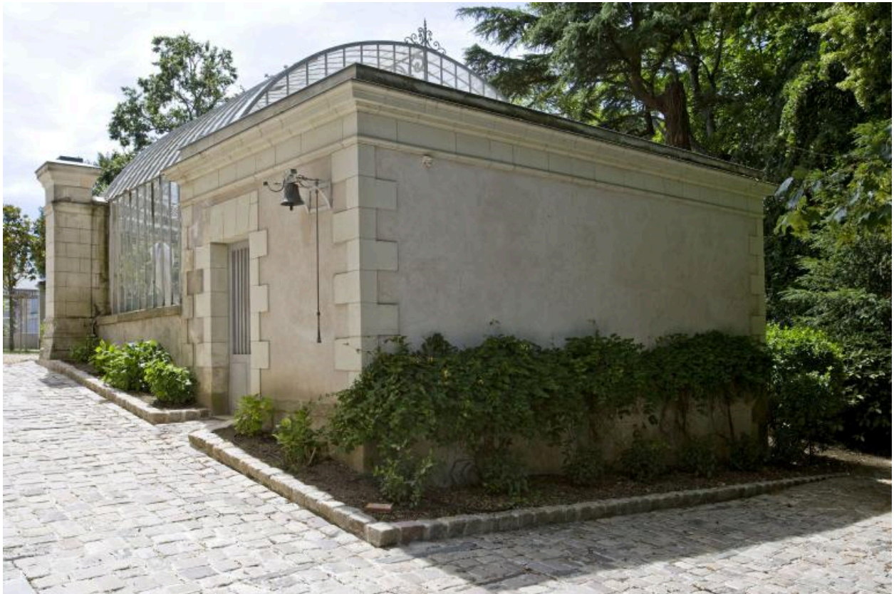
La serre : bâtiment abritant la chaufferie.
