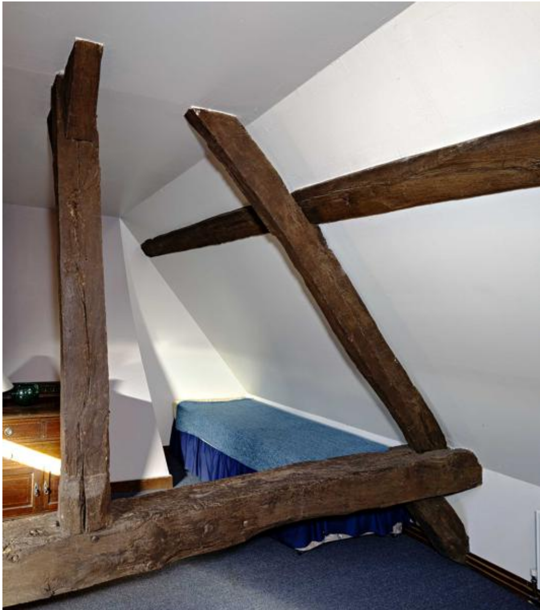
Ferme de charpente
