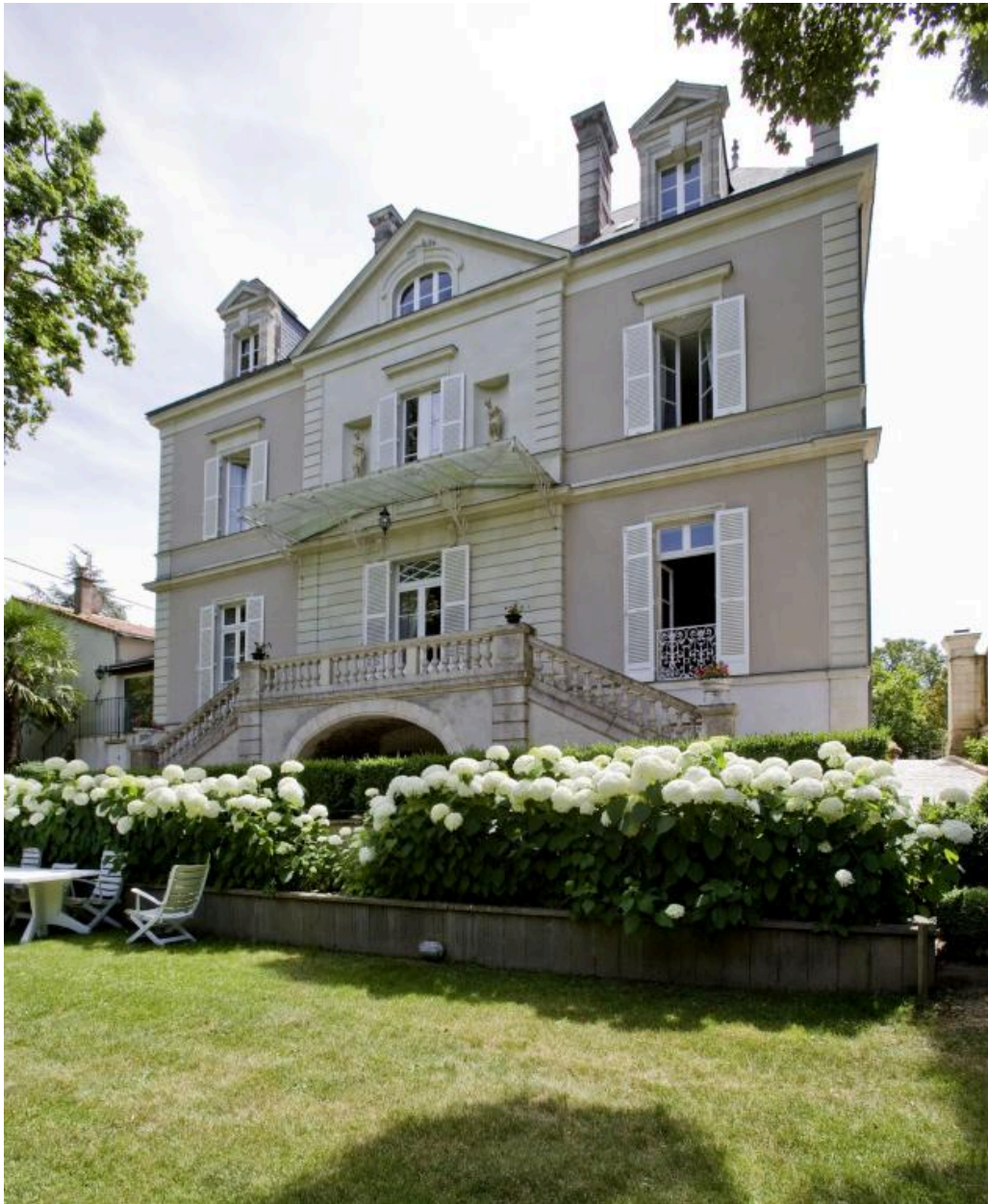
La maison : façade nord sur jardin.
