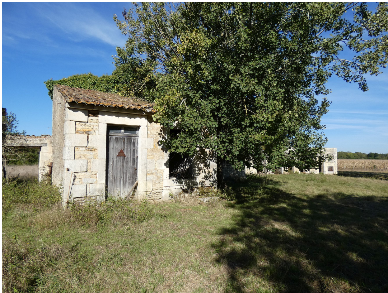
La buanderie vue depuis l'est.
